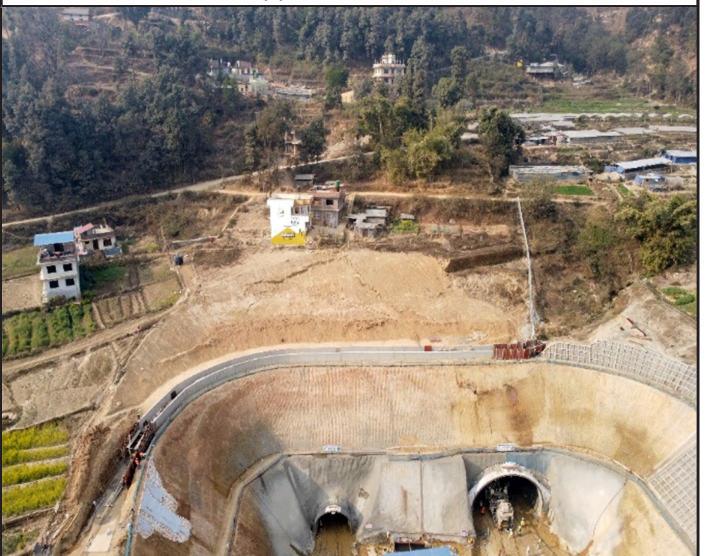
(d) Two parallel Tunnels at East Portal
