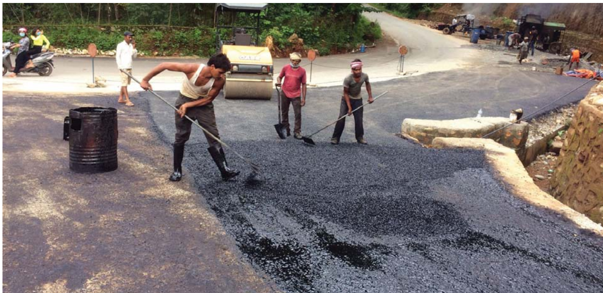
सडक कालोपत्र गरिँदै : राष्ट्रिय गौरवको आयोजनामध्येको एक मध्यपहाडी पुष्पलाल लोकमार्गको पोखरा-बागलुङअन्तर्गत बागलुङ नगरपालिका-१ रामरेखामा सडक कालोपत्र गर्दै श्रमिक । रामरेखाको सहिद पार्क अगाडि साँघुरो सडक विस्तार भएपछि कालोपत्रे गरिएको हो । तस्बिर : रासस
