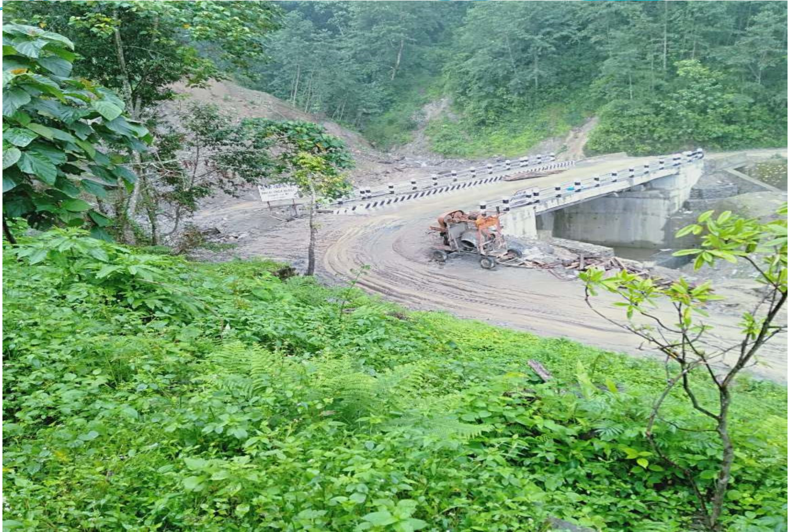
भुल्के खोला पुल, खोटांग
