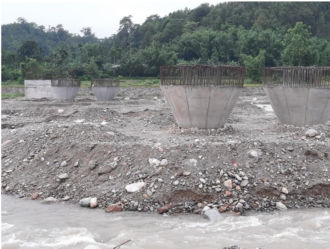
Biring Khola Bridge मदन भण्डारी राजमार्ग धरान-झापा खण्ड
