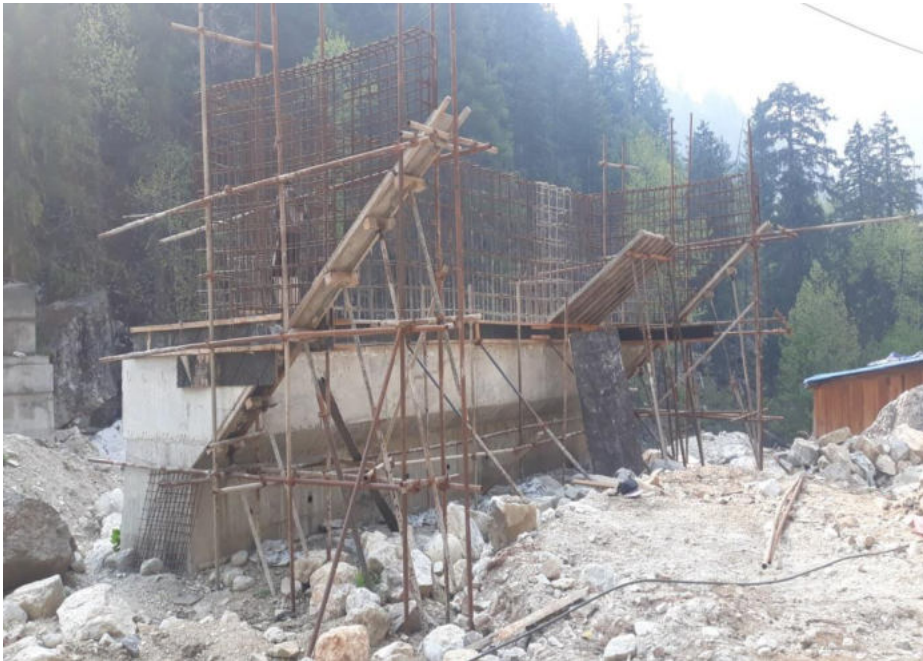
(सल्ली खोला पुल, हिल्सा-सिमिकोट सडक खण्ड, चेनेज : ६२+०००, Abutment cap सम्म निर्माण भएको)
