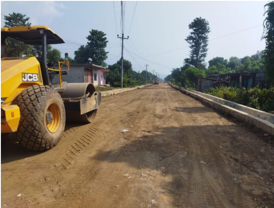
बोटेचौर-भेडाबारी-धुलियाबिट सडक खण्डमा भैरहेको Subgrade Preparation Works
