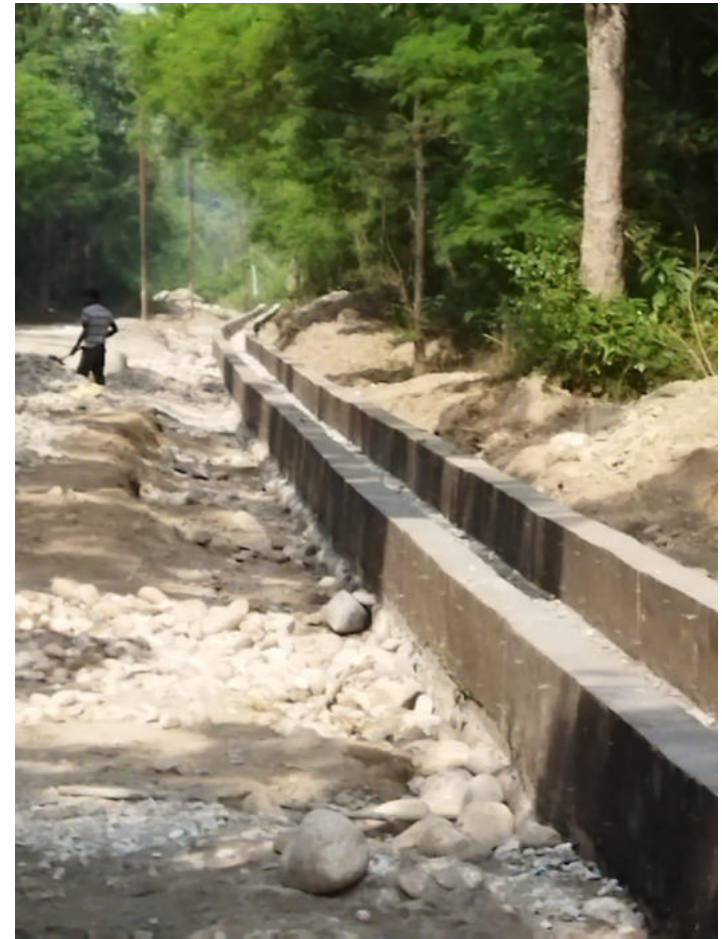
बोटेचौर-भेडाबारी-धुलियाबिट सडक खण्डमा भैरहेको Side Drain Works
