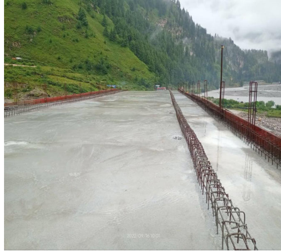
(Deck Concreting, छतांग खोला पुल, छतांग, घाँसा जोमसोम सडक खण्ड)
