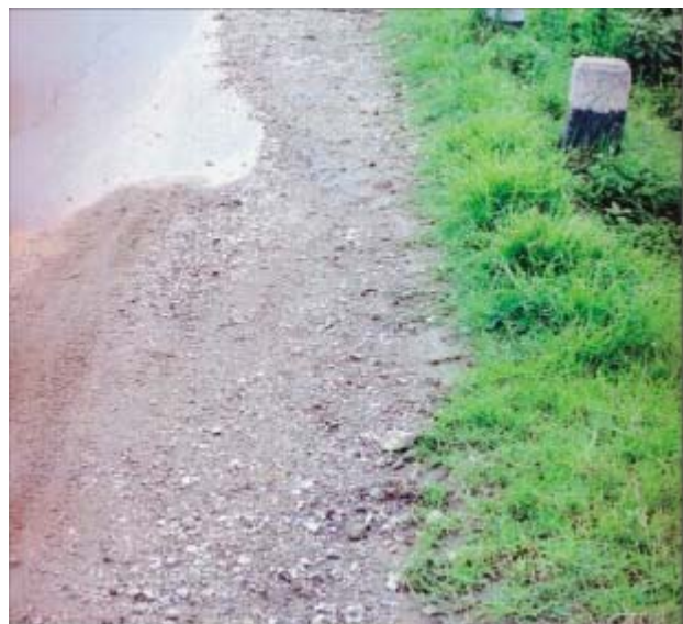
पानीले बगाएर ल्याएको ढुंगा माटो जम्मा भई अग्लो भएको सडक किनारा
