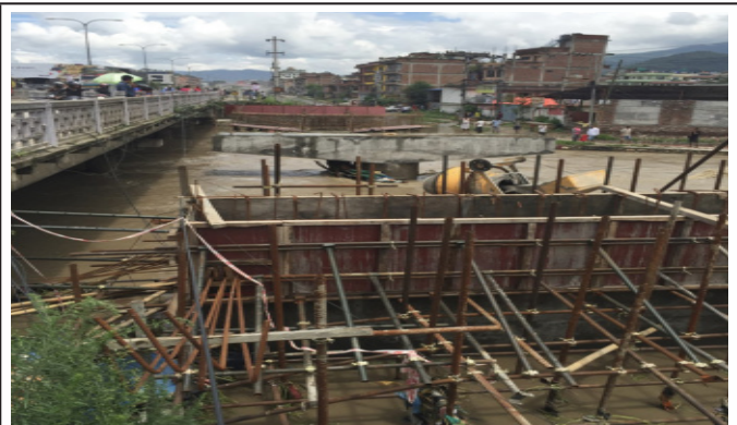
(d) Construction of substructure
