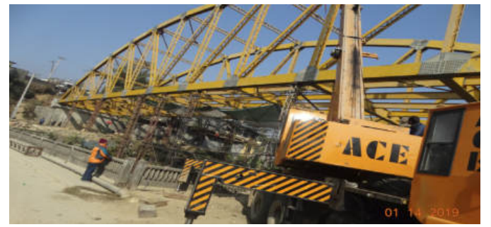
(d) Truss erection-remaining portion
