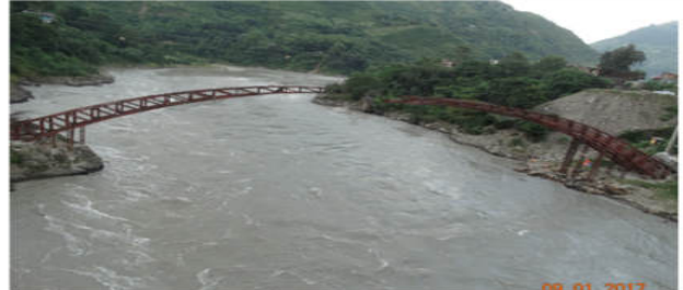
(d) Construction of temporary work for arch erection
