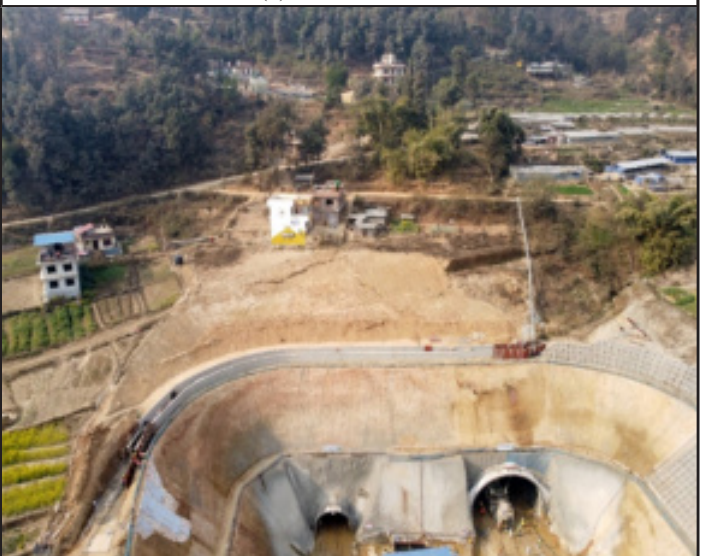
(d) Two parallel Tunnels at East Portal
