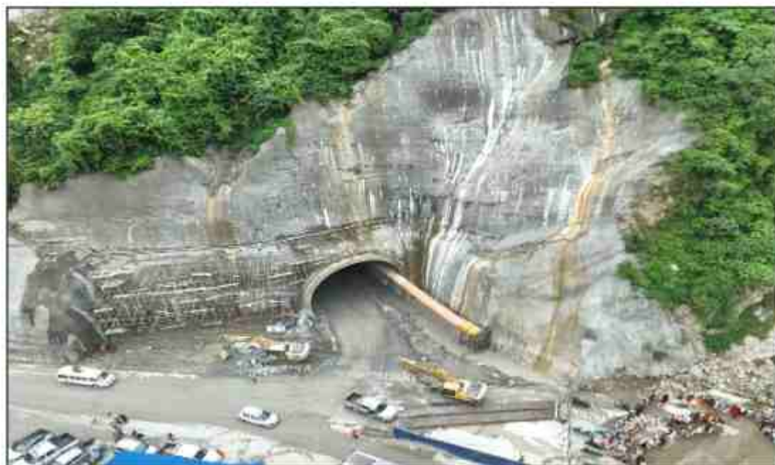
सिद्धबन्ना टनेल निर्माण कार्य
