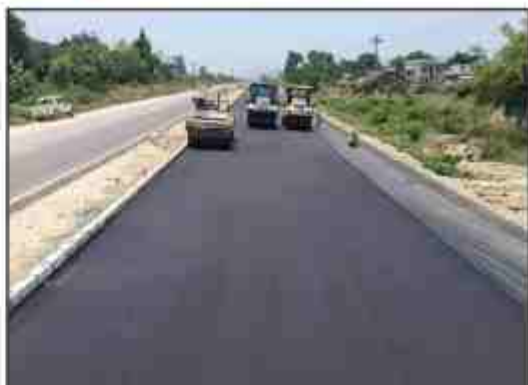
कमला - कन्चनपुर सडक खण्ड अन्तर्गत कालोपत्रे कार्य
