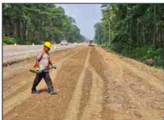
काकरभिला - लौकही सडक खण्ड अन्तर्गत माटो फिलिंग कार्य
