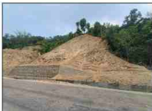
नागदुंगा - मुग्लिन सडक खण्डमा ब्रिजईन्जिनियरिंग कार्य
