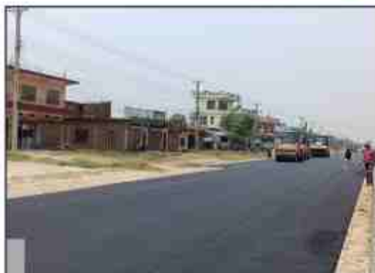
नारायणघाट - बुटवल सडक खण्ड अन्तर्गत कालोपत्रे कार्य
