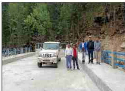
कर्णाली करिडोर अन्तर्गत सम्पन्न भएको सल्ला खोल पुल (चैनैव ६२०७०)
