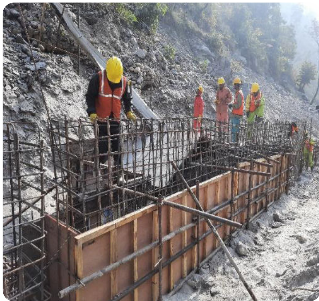
5.6 (d): Construction of Pile Cap
