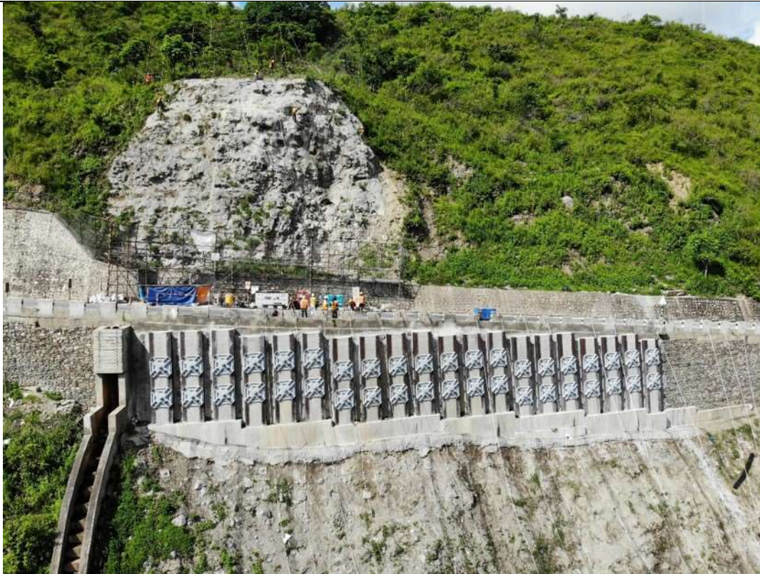
धुलिखेल-सिन्धुली-बर्दिबास सडकमा H Beam Installation for Slope Protection
