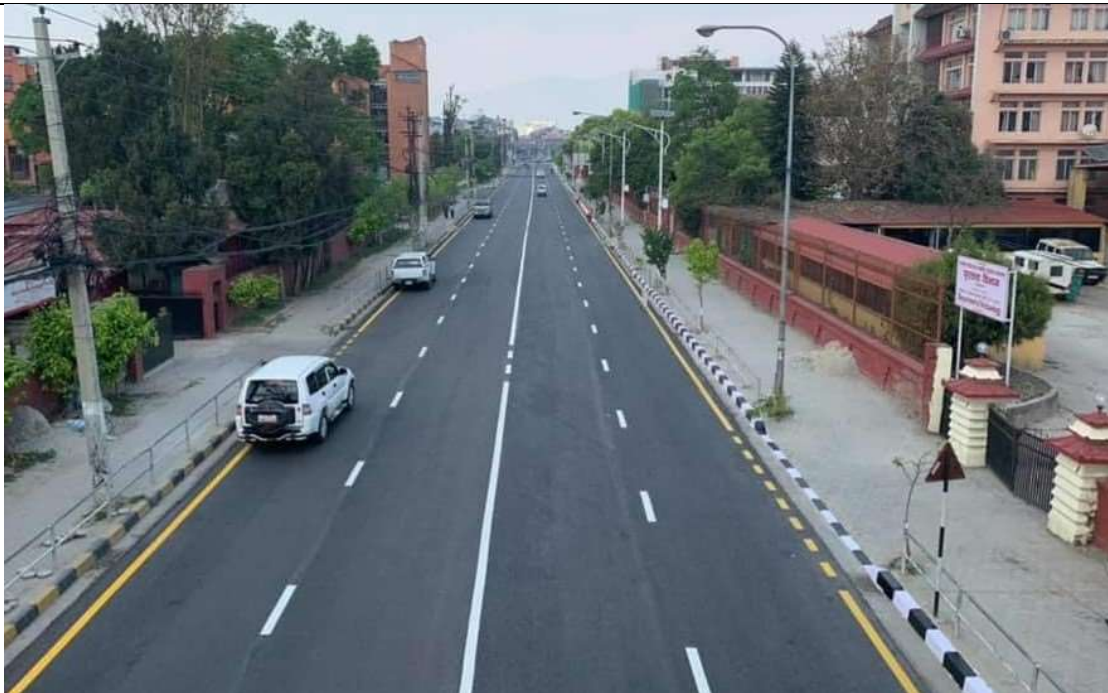
आवधिक मर्मत पश्चात माइतीघर-सिंहदरबार सडक
