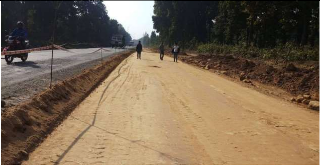
नारायणगढ-बुटवल सडकमा Embankment Filling Works, Ch 28+000 Km
