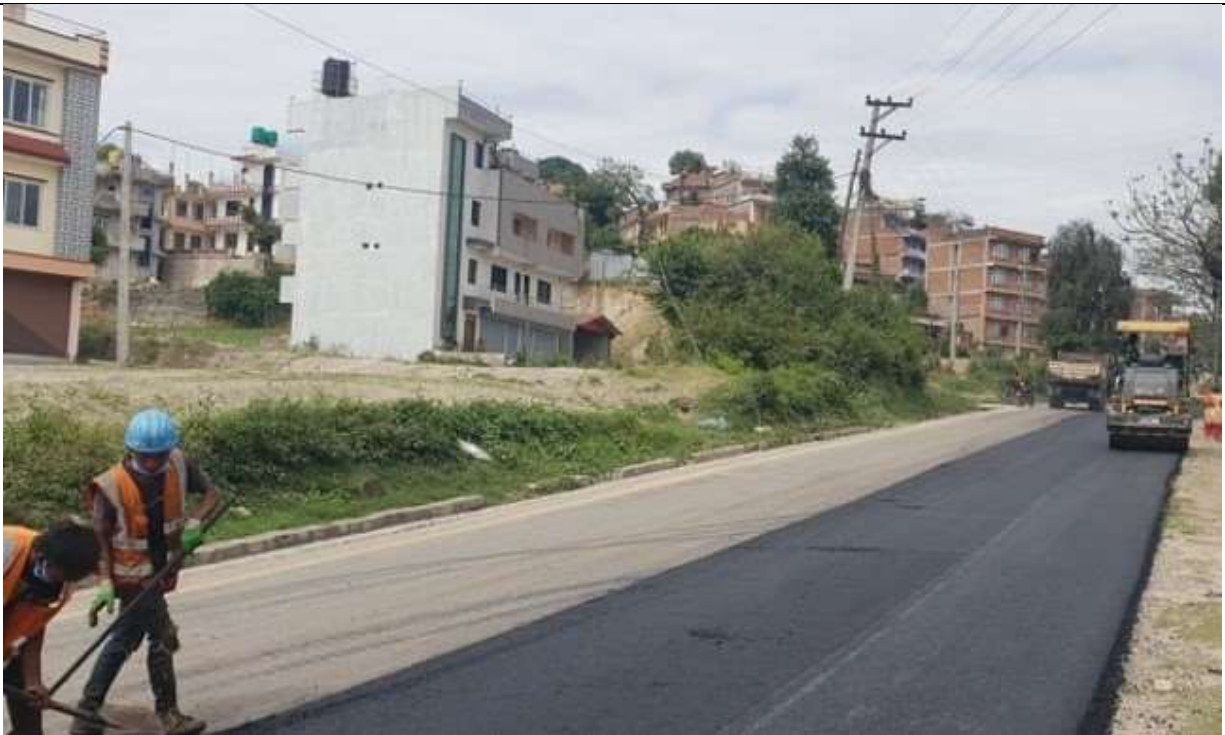
अरनिको राजमार्गको जगाती साँगा सडकमा आवधिक मर्मत कार्य
