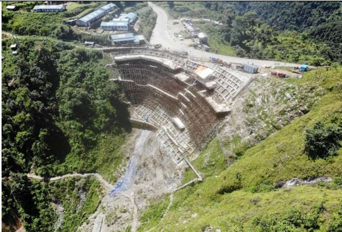
धुलिखेल-सिन्धुली-बर्दिबास सडकमा Crib wall works for Slope Protection
