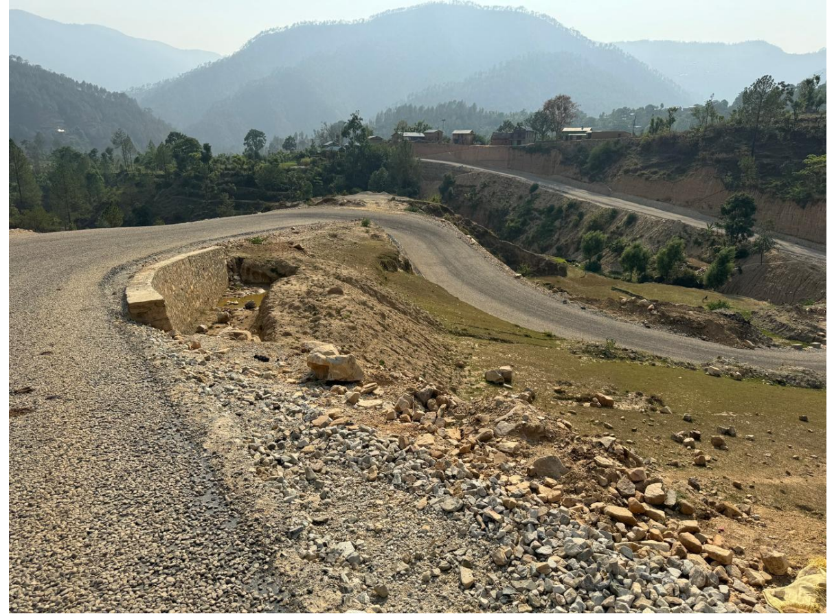
(खलङ्गा - कालिमाटी - मार्के सडकको चेनेज २+८०० मा भएको DBST कार्य )
