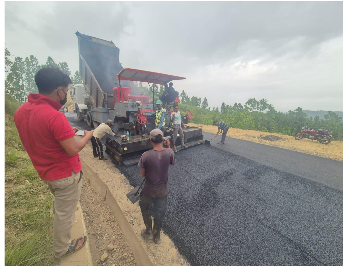
(राप्ती राजमार्गको चेनेज १३+१०० मा Asphalt प्रविधिबाट हुँदै गरेको राजमार्ग स्तरोन्नती कार्य)
