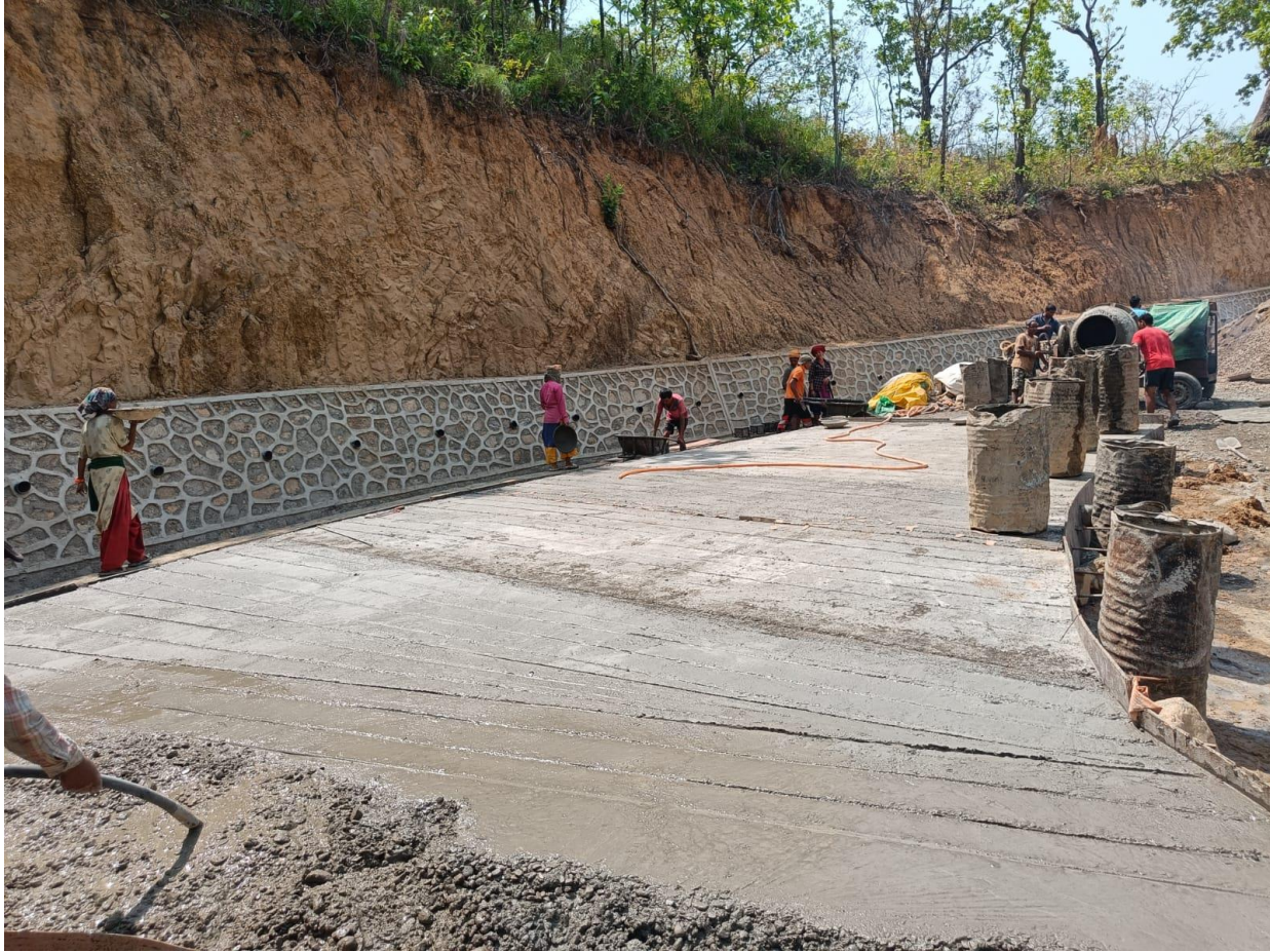
(बबई गाउँपालिका अन्तर्गत पर्ने श्रीमणी मार्गको चेनेज ४+५०० मा भएको Rigid Pavement कार्य)
